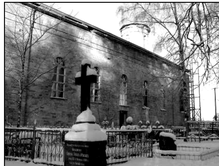
д. Петрово (с. Новые Скворицы) приход Скуоритса, ц. Св. Екатерины. Архитектор А.М. Байков 1834 г. Закрыта в июле 1939 г. Восстанавливается.
