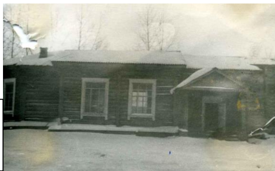
С.Турово. Здание бывшей церкви. Построено в 1912г. С 1936г. был сельский клуб. Разрушен в 80-е годы XX в.
