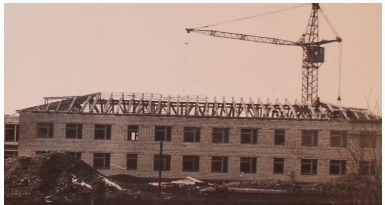
Фото 26. Строительство новой школы.
