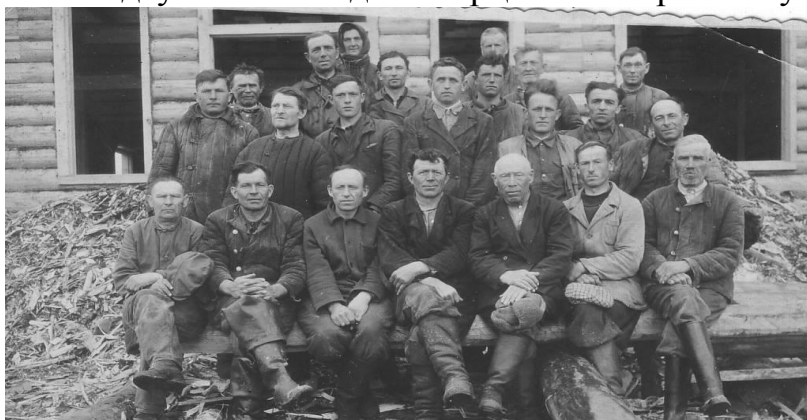
Бригада строителей Ярцевской школы
