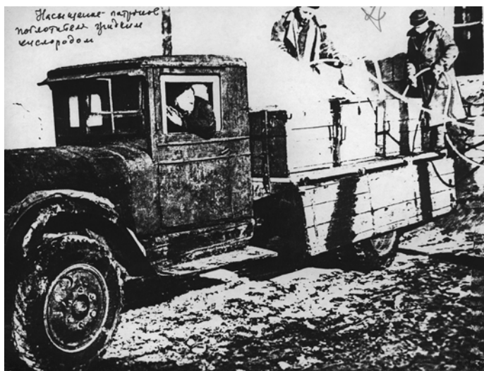
Насыщение патронов поглотителя жидким кислородом. Работают заключенные Норильлага
