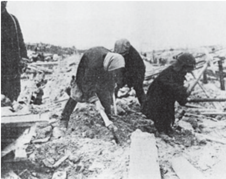
Детский труд на канале № 182. 1933 г.
