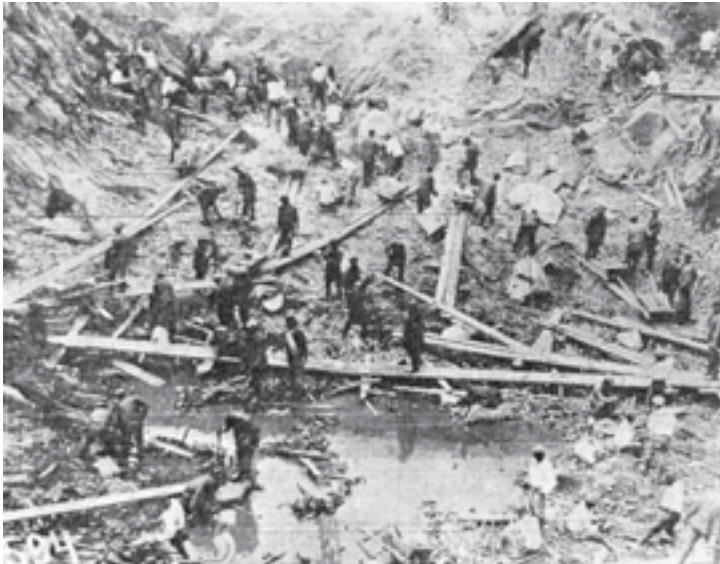
Работа в котловане шлюза № 11. 1932 г.
