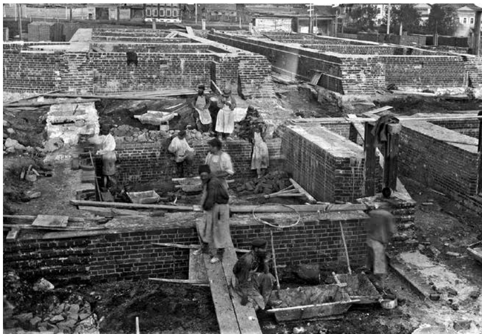
Строительство здания Енисейской женской гимназии. Из фондов КККМ.
