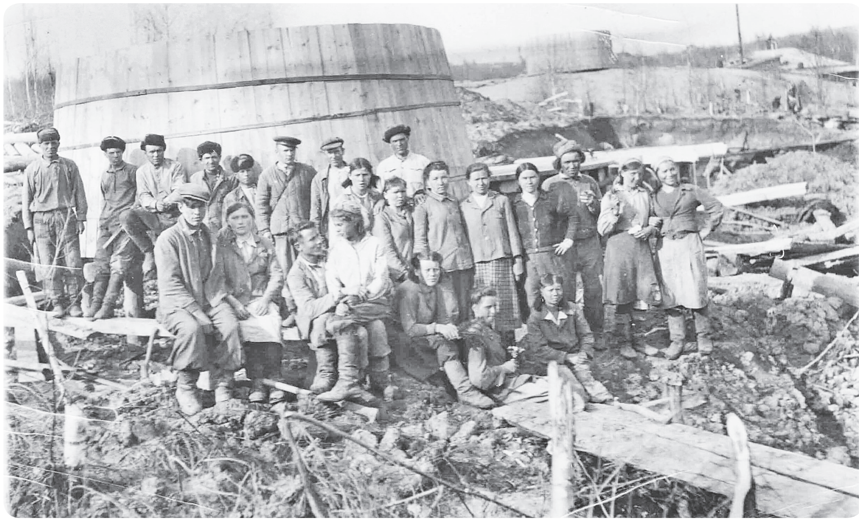
На строительстве илового завода
