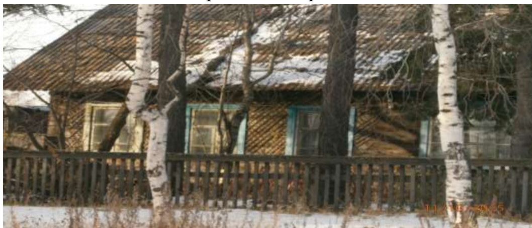
Покрытие стен дранкой
