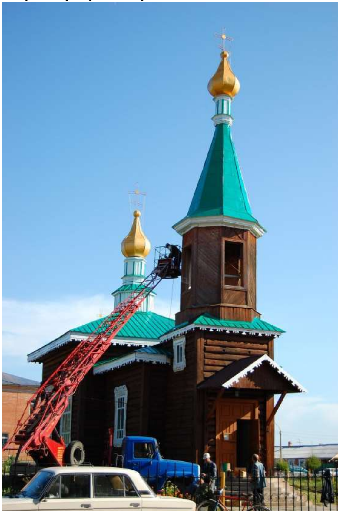
Косметический ремонт 2004г.
